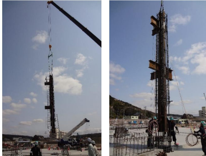
②柱をクレーンで慎重に建てる位置へ移動します。
