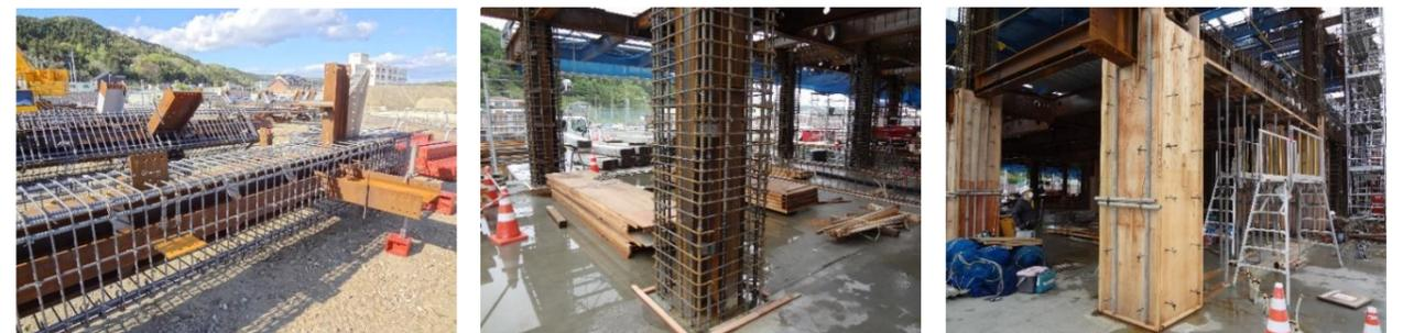
SRC造は鉄骨に鉄筋コンクリート施した構造体です。鉄骨の組立て前に鉄筋を取付け、組立て後は周囲に型枠を設置しコンクリートを流し込みます。これによって強固な構造体が完成します。
