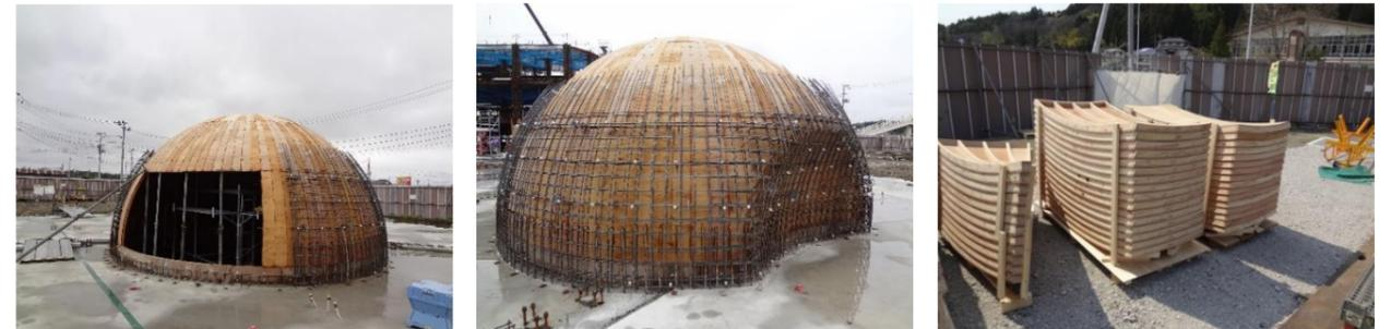
図書館内に設置する『おはなしのへや』の状況です。5～6歳の子ども達に絵本の読み聞かせをしたり、映像資料の視聴などを想定しているスペースです。丸い特徴的な形をコンクリートで作成するため、それに合わせて木の型枠や鉄筋も曲線で仕上げています。
