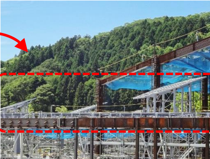
屋根のアクセントにもなっています。この部分は施設の換気・排煙と採光をとる部分にもなります。
