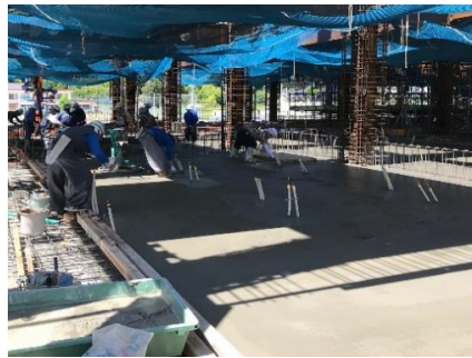
検査後にコンクリートの打設をしました。2階床の完成です。
