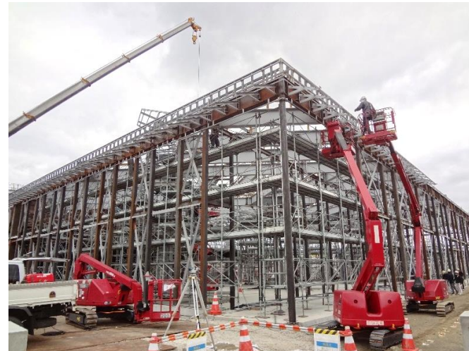
③北西から
