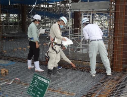
2階床の鉄筋を組んだ後に建築確認の中間検査を行いました。
