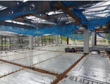
2階の研修室部分です。広く使うのはもちろんですが、小さく区切って使うことも可能です。
