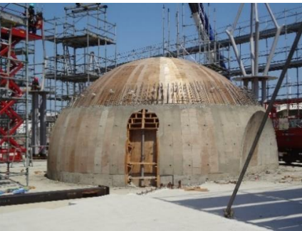
おはなしのへやのコンクリートの一部ができました。
