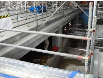
多目的ホールの地下部分です。ここに昇降式の床が収納されます。
