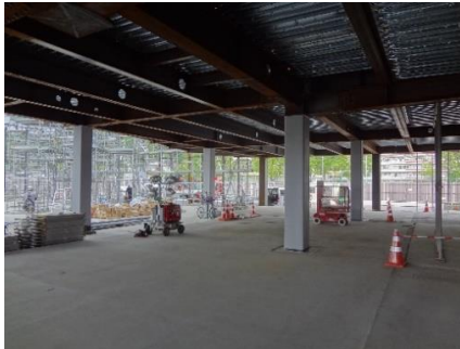
1階の事務室部分です。施設は、指定管理者による管理運営を行います。
