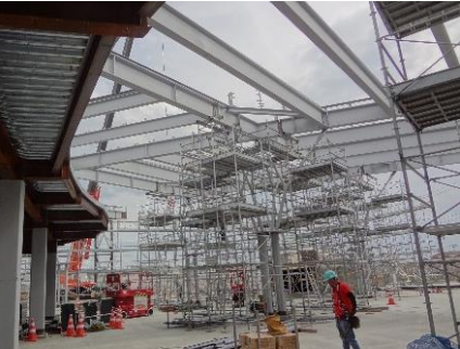
図書館の天井は鉄骨がひし形に組まれています。強度的な意味合いとデザイン的な要素も持ち合わせます。
