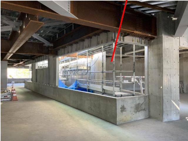
2階の中廊下に光を取り入れる光庭です。
