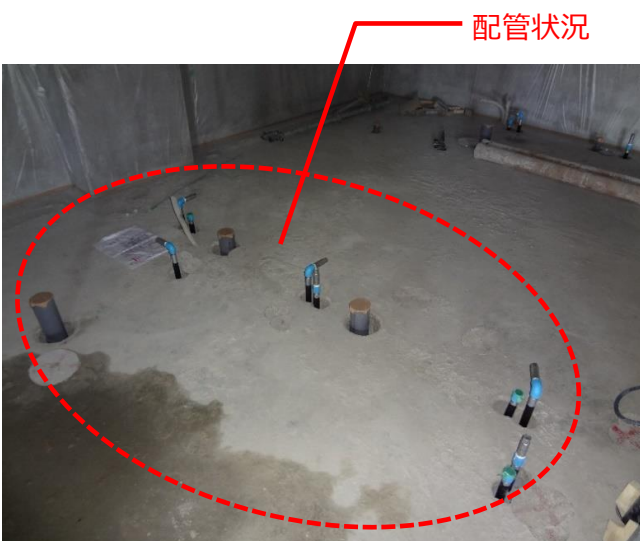
2階トイレの配管。事前に配管してから床コンクリートを打設しています。
