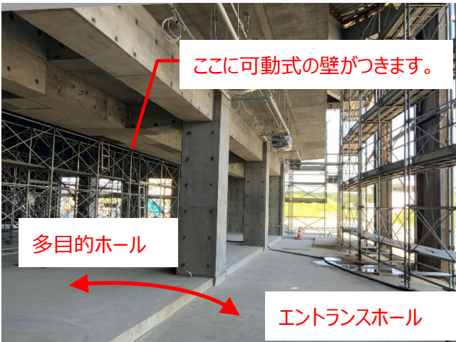
多目的ホールの入口です。エントランスホールとは可動式の壁で区切られており、一体的に使うことが可能です。
