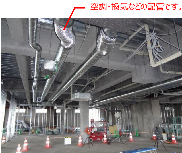
事務室部分です。設備の配管が見えます。天井を張ると見えなくなる部分です。
