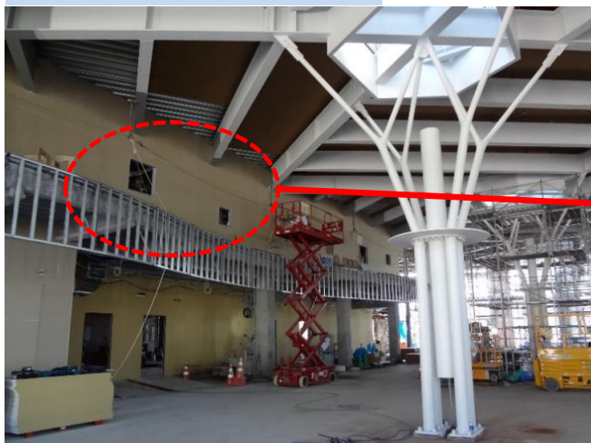
②2階公民館部分の様子
