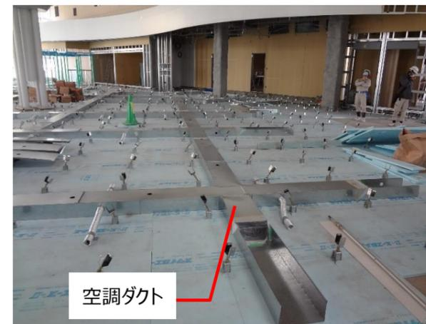
図書館は床下に空気式床暖房を備えています。現在はそのダクト工事中です。青色のものは床の断熱材です。
