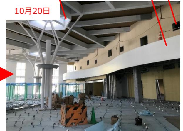
鉄骨の骨組みにボードが張られて綺麗な曲線が出来上がりました。窓のランダム配置、エコツリーと併せて有機的な空間の図書館となっています。
