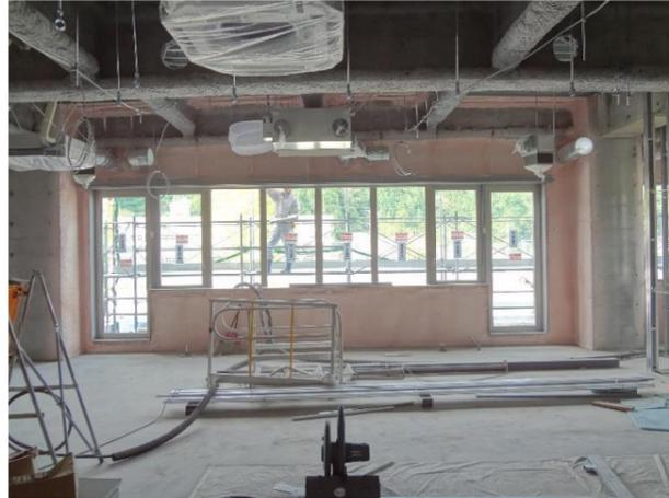
創作室 1 の様子です。窓の外はバルコニーとなっています。壁にはピンク色の断熱材が吹付けられています。
