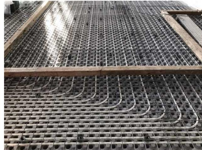
1階のエントランスホールの様子です。エントランスホールの一部は床冷暖房が入っており写真はその配管の様子です。夏場は冷水、冬場は温水を循環させて冷暖房を行います。
