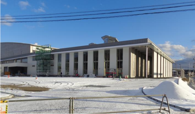
◆北西側から撮影（利府中学校側入口）
