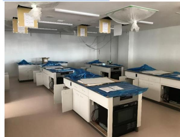
クッキングスタジオの様子です。調理台の据付が完了し、配管や電気配線の仕上げを行っています。
