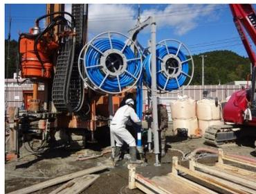
ブルーの管に不凍液を充填し、地中の熱を回収します。
