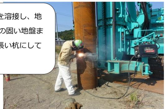
杭同士を溶接し、地下30mの固い地盤まで届く長い杭にしています。
