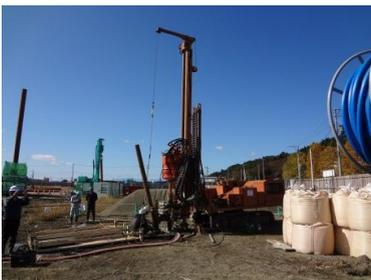
ボーリングマシンで地下100mまで掘削します。
