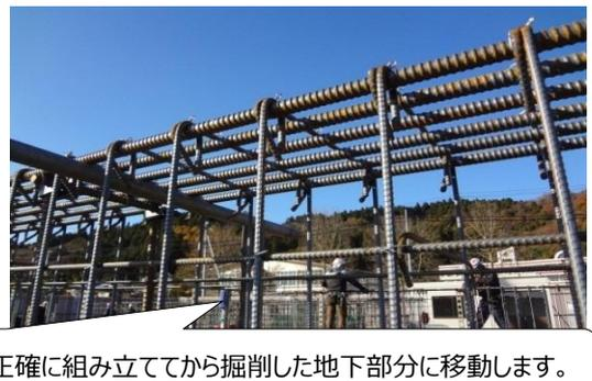
地上で正確に組み立ててから掘削した地下部分に移動します。
