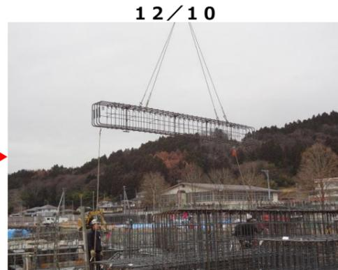
地上で組立てた鉄筋をクレーンで地中へ移動。
