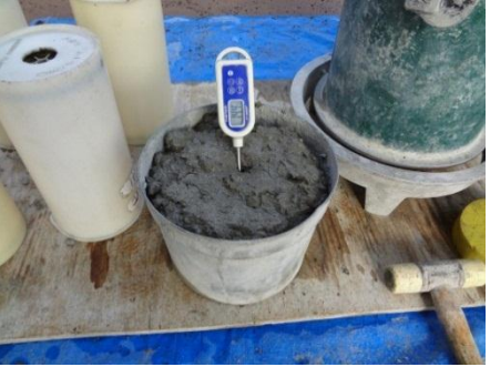
コンクリートの温度を測定する。 ※冬場は10～20℃以内とする。
