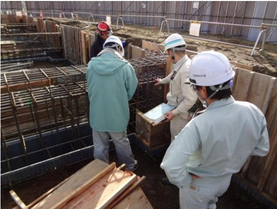
1月9日 図書館部分の検査を行いました。
