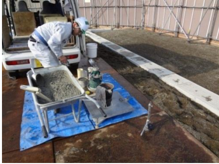
到着したてのコンクリートの一部を試験用に採取する。
