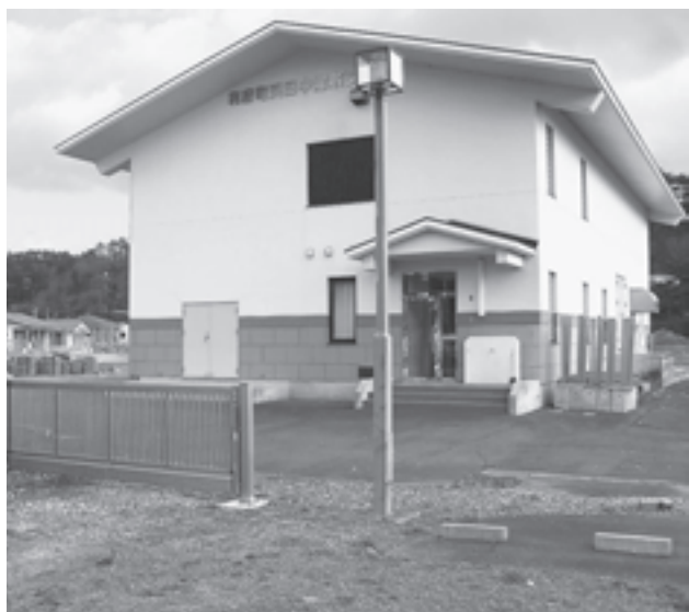
電源が故障した「浜田中継ポンプ場」
