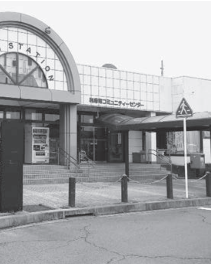
トイレ以外の改修は
