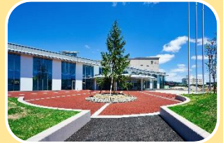
← リフノス外観
