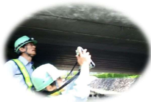
【タブレットによる点検】
