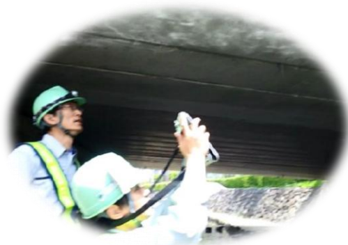
【タブレットによる点検】
