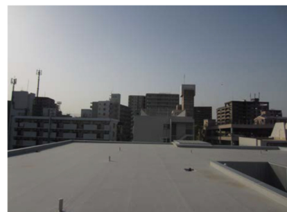
＜事例＞シート防水 (福岡県 民間共同住宅)
