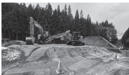
地下水に影響しないよう残土を排出
