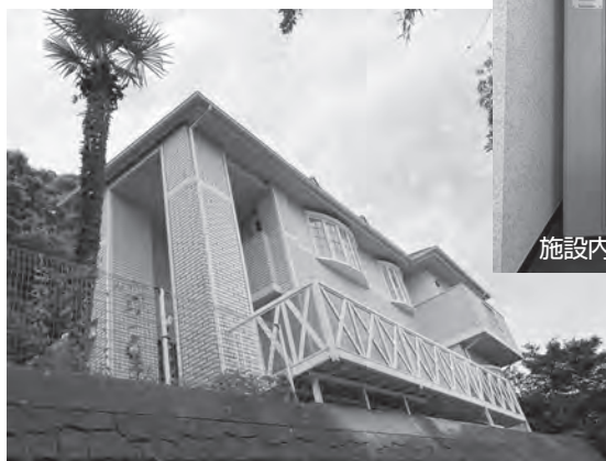
浜田地区にある「e-ハマハウス」の1人用のサウナを改修します
