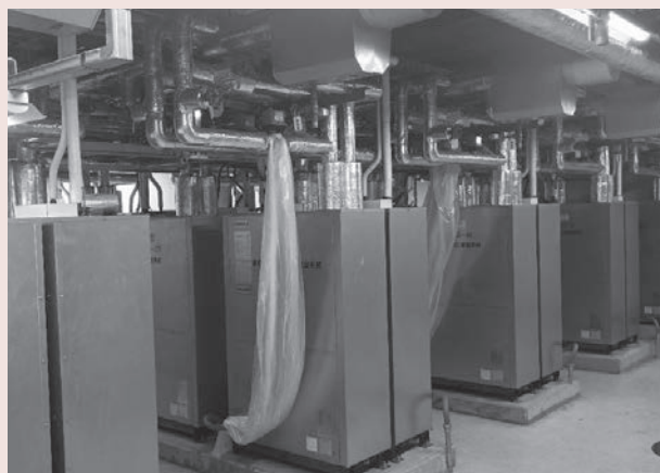
庁舎地下にある受変電設備を地上に移動します
