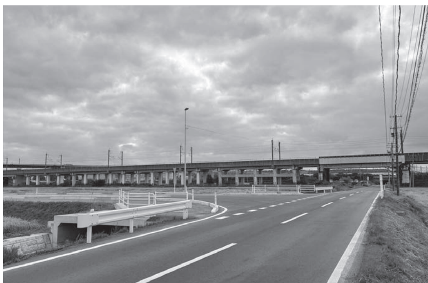
混雑緩和に利用してほしい新道路
